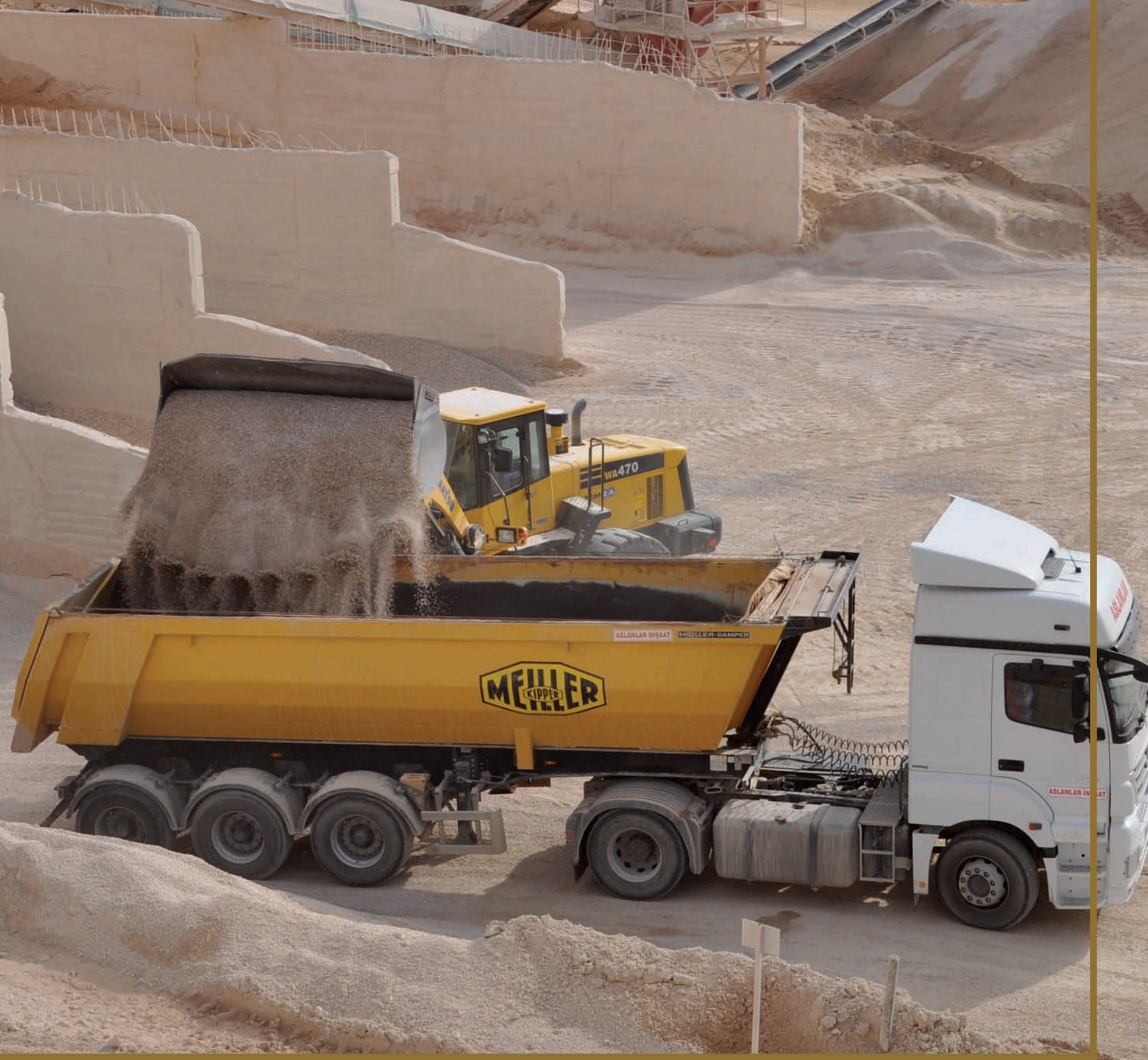
Bandırma, Edincik'teki Agrega Kırma Eleme Tesisimiz
