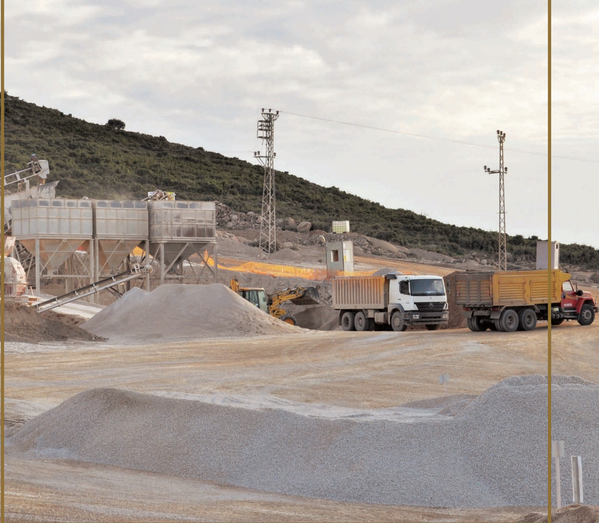
Bandırma, Edincik'teki Agrega Kırma Eleme Tesisimiz
